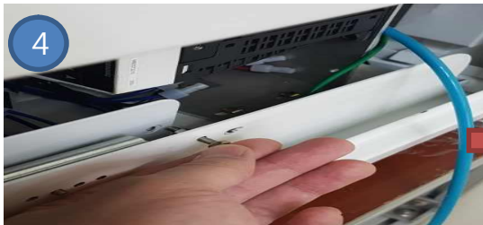
4 내부에 고정볼트 풀고, controller를 앞으로 당겨 작업공간을 확보한다. (육각렌치 사용)
